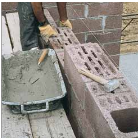
Posa di muratura armata in Lecablocco.
